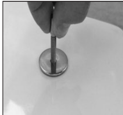
03 Avvitare il fissaggio tenendolo sollevato ma non bloccare. Tighten the fixing screw by keeping it lifted do not block.
